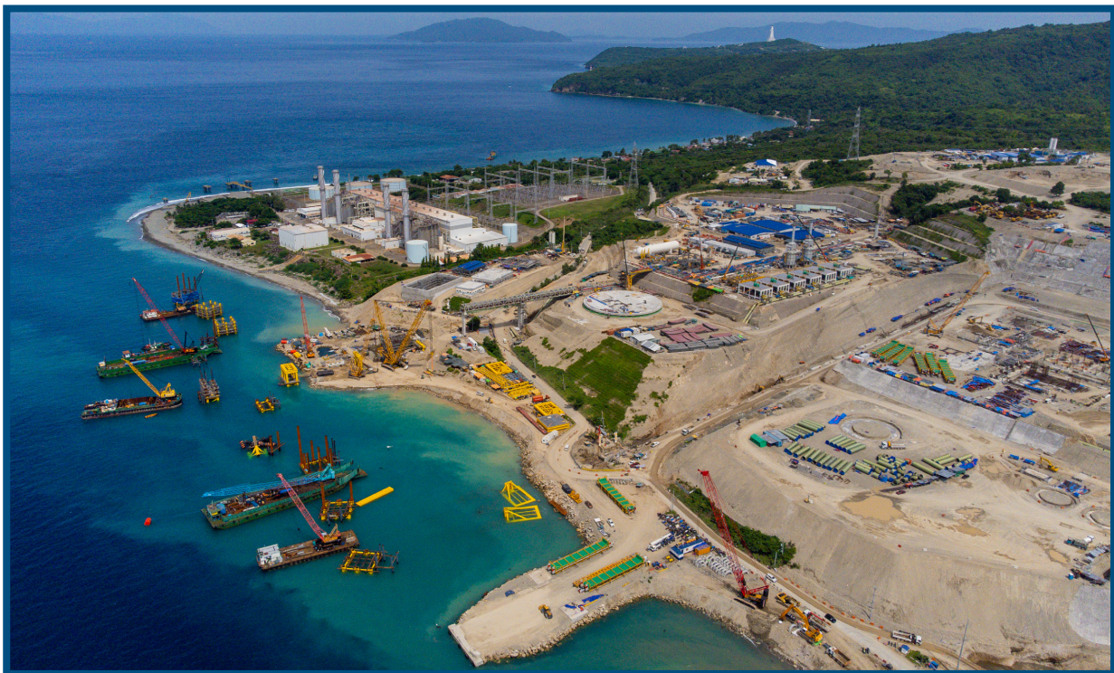
フィリピン・マニラの南、バタンガス州での石炭火力発電所新設工事の様子。写真: Basilio Sepe
