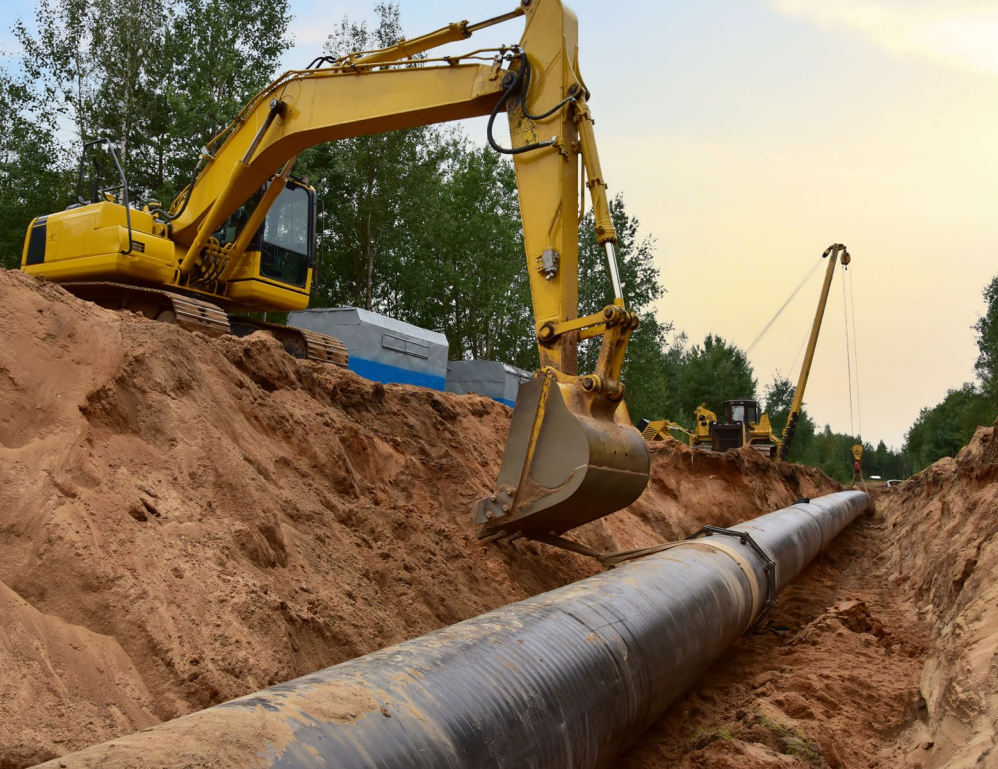
Un Gazoduc en construction, par MaxSafaniuk, Adobe Stock stock.adobe.com
